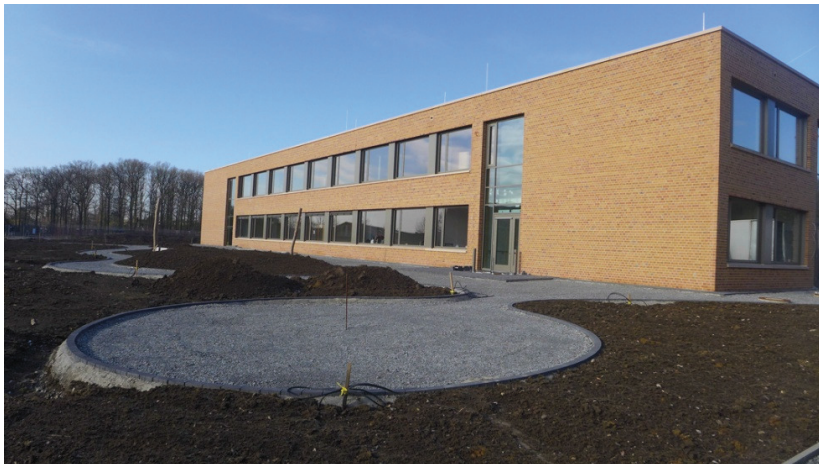
Bild 3 – Schulneubau in Oelde
